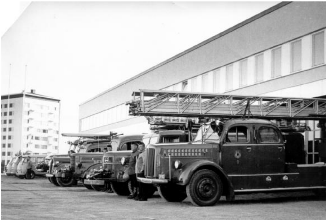
Perillä Satakunnankadun uudella paloasemalla
